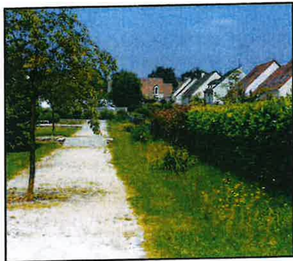
CIRCULATION DOUCE EN STABILISE
