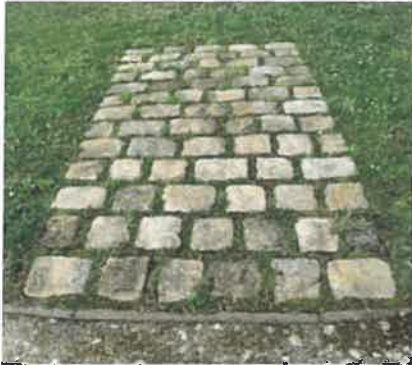
Pavés grès place de l'Eglise de Champmotteux
